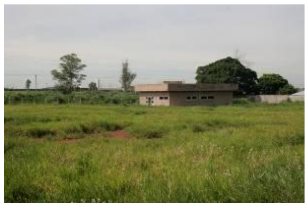
Vista do Necrotério. Mato já se espalha pelo terreno.
