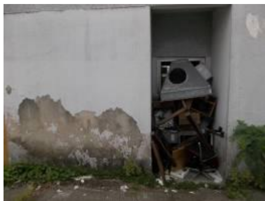
Vista de fora da saída de emergência
