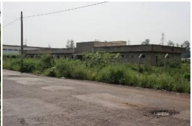
Área indica paralização total das obras.
