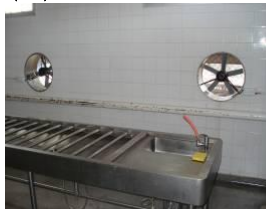
Exaustores ficam em altura abaixo da mesa de trabalho. NPML Bauru - UR-02
