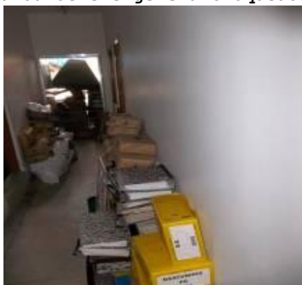
Saída de emergência bloqueada por arquivos, caixas e móveis.
