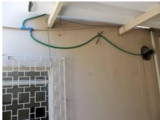
Vista de fora do prédio Ligação da água da rua EPC Osasco DCG-2
