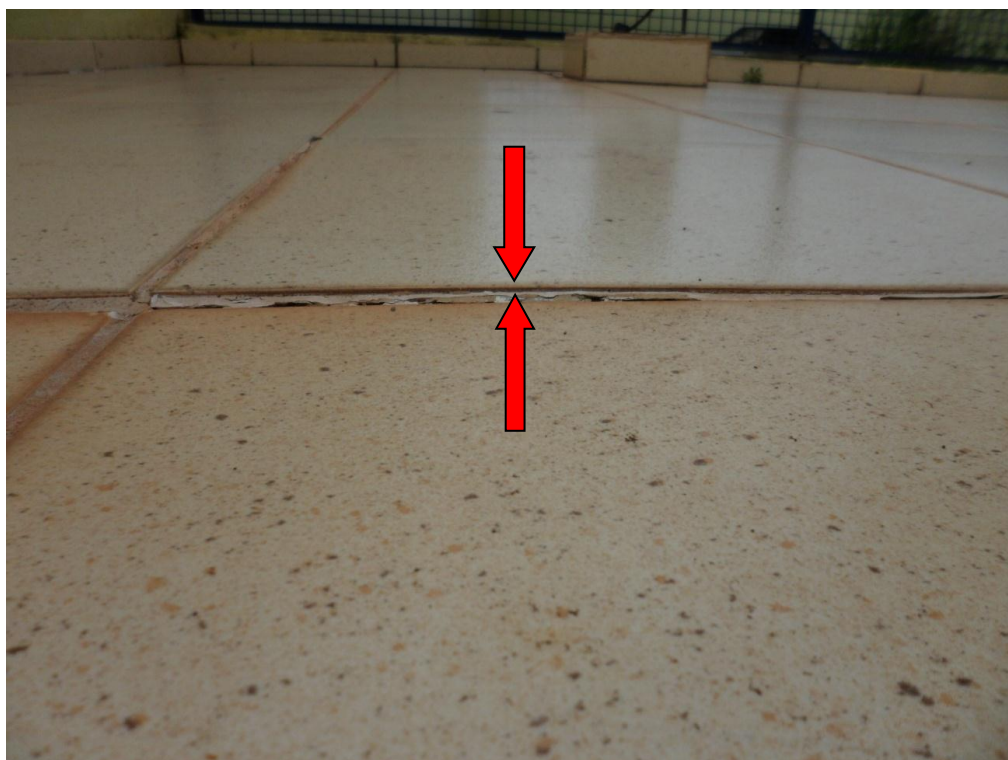
Ilustração 20 – Movimentação revestimento do piso do terraço B
