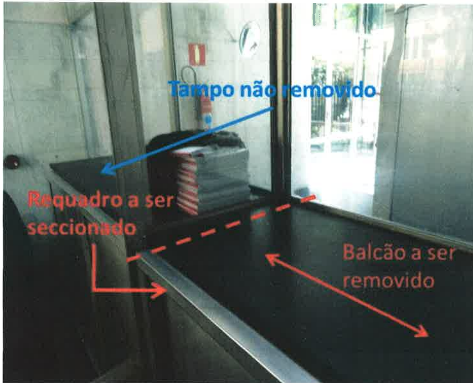
Foto 04 – Indicação do seccionamento do balcão e peças a serem removidas.
