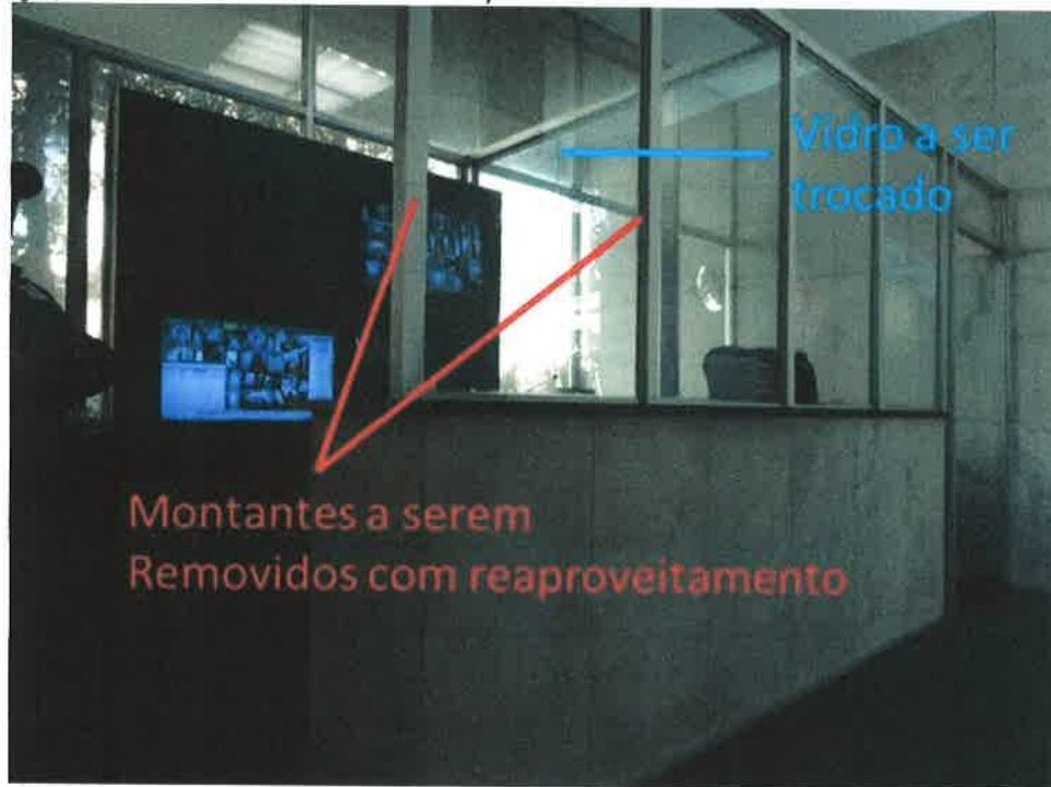
Foto 03 – Indicação das esquadrias de alumínio e vidros a serem desmontados.
