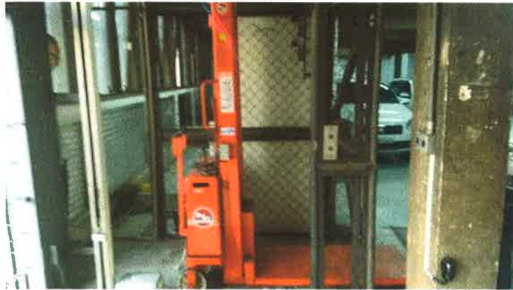
Foto - Estrutura metálica e empilhadeira, 4º subsolo.
