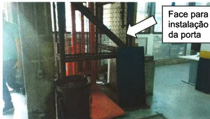
Foto – Estrutura metálica, 4º subsolo.
