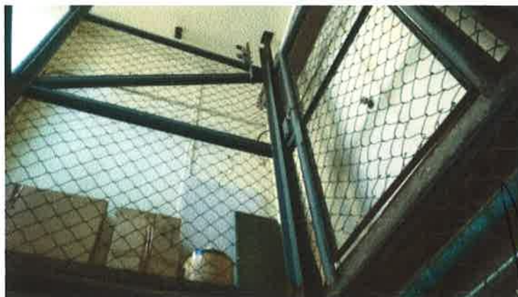
Foto – Estrutura metálica no 3º subsolo.
