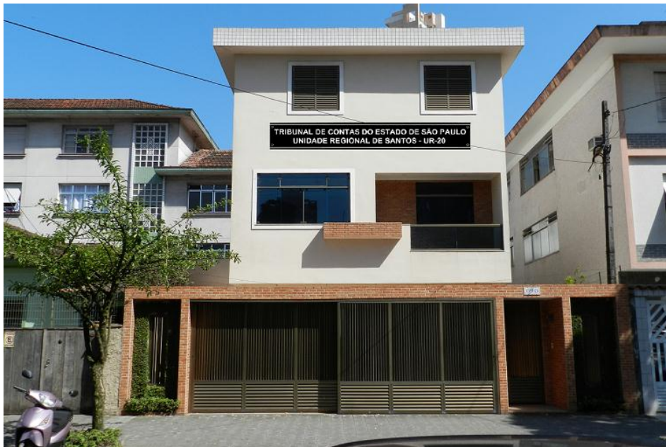
Figura nº 4: posicionamento da placa de identificação na fachada
