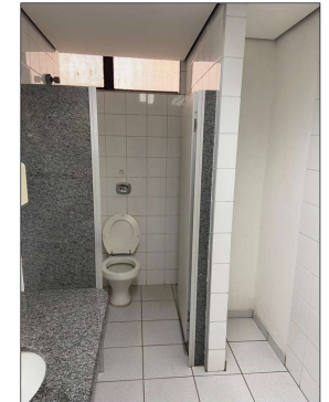
Sanitário Gabinete Situação atual
