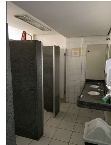
SANITÁRIO MASCULINO Situação atual
