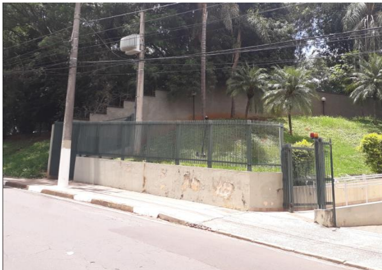
Foto 14 – Portão metálico de divisa.
