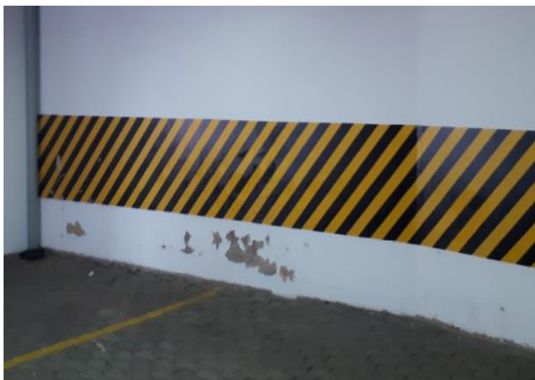
Foto 15 – Sinalização “zebrada” a ser “reforçada”.
