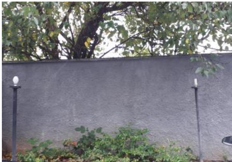
Foto 13 – Muro de divisa – cor cinza.
