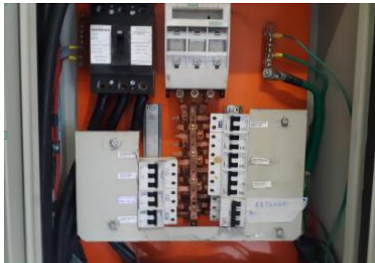
Foto 6 – QDE a ser reformado.
