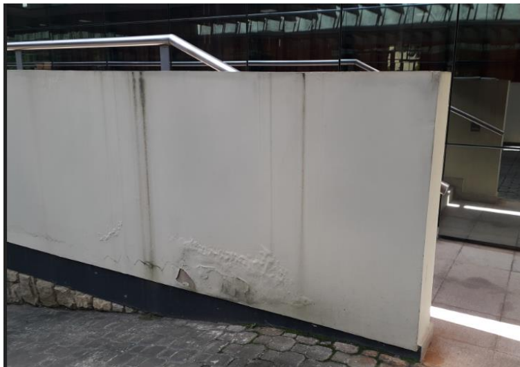
Foto 11 – Muretas e outros elementos de alvenaria – cor “areia” ou “concreto”
