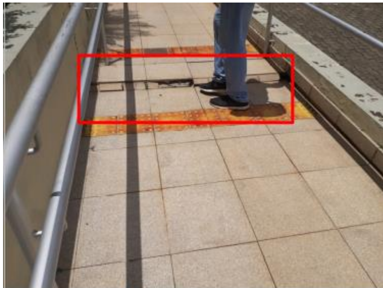
Foto 1 – Área da rampa prejudicada.
