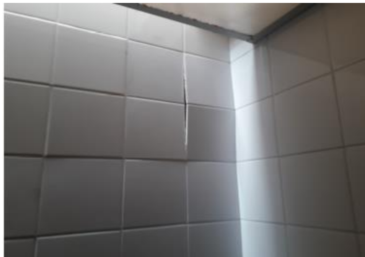
Foto 3 – Azulejo com assentamento prejudicado.
