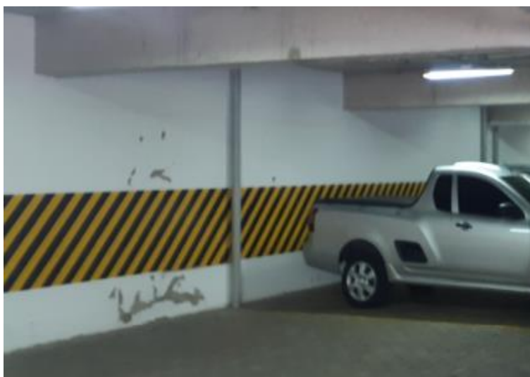
Foto 5 – Infiltração junto à parede externa da tubulação.
