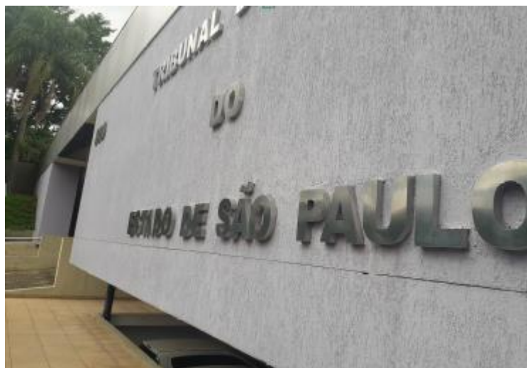
Foto 10 – Fachada principal – cor “roxa”.
