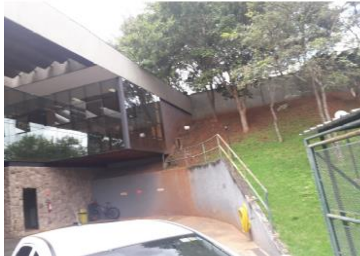
Foto 4 – Mureta a ser acrescida altura.
