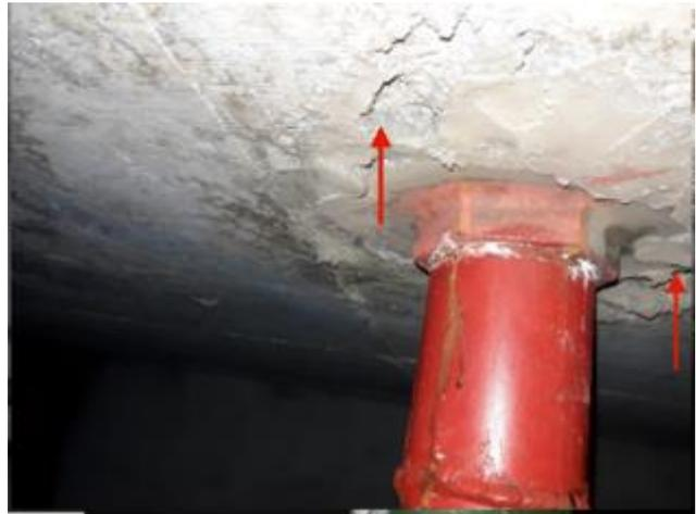
Foto 6 – Indício de oxidação da armadura da base.
