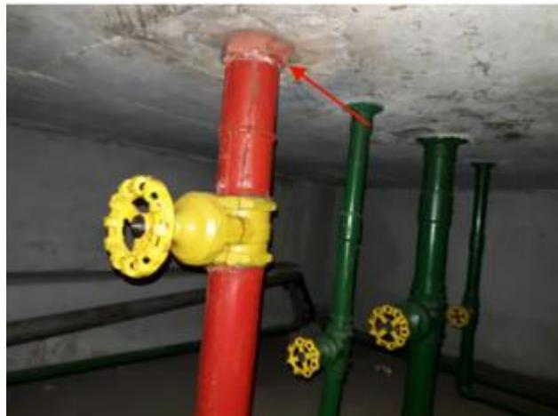
Foto 3 – Conexão com flange da tubulação do sistema de hidrante
