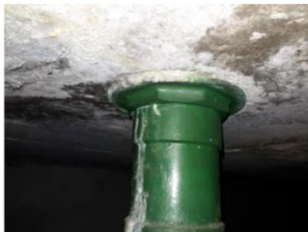
Foto 5 – Conexão com flange para tubulação de 4”
