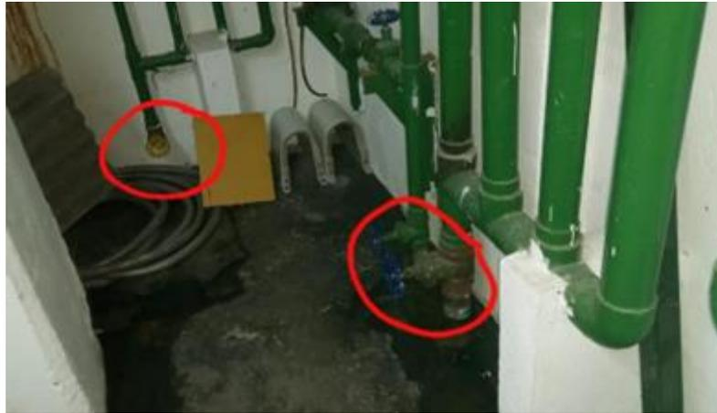
Foto 8 – Registro a ser substituído (local: sala técnica subsolo)
