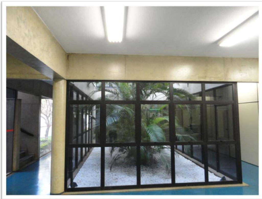
Sala de atendimento - Térreo
