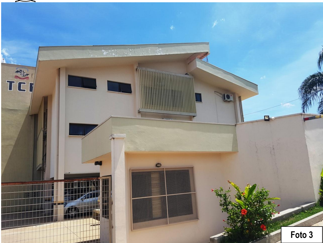
Beiral com desgaste da pintura e muro sem proteção por rufo metálico.
