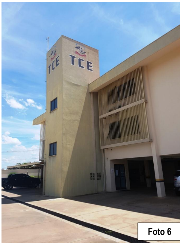
Torre do Elevador com desgaste da pintura
