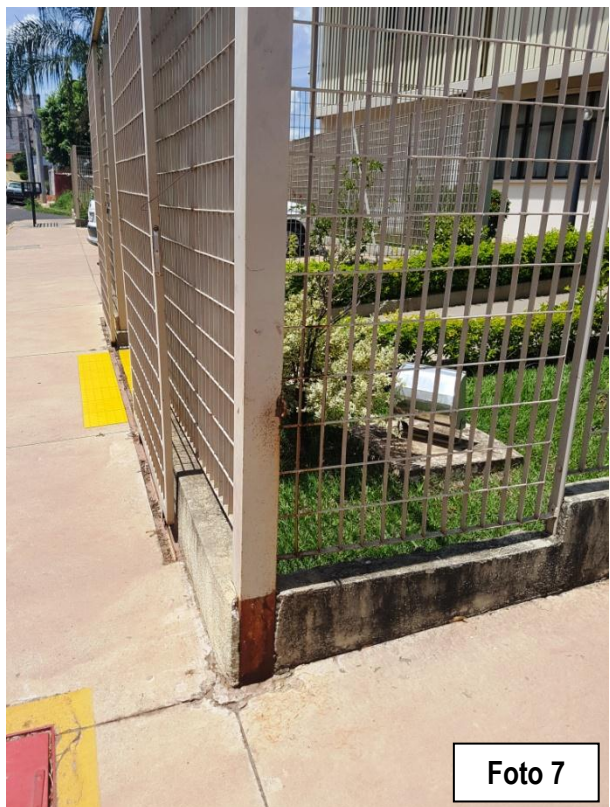
Gradil Externo apresentando pontos de ferrugem
