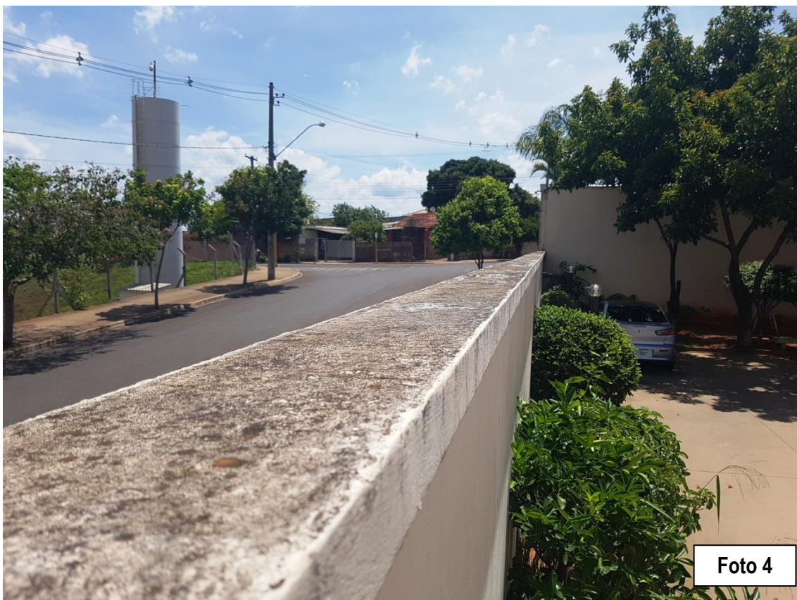
Beiral com desgaste da pintura e muro sem proteção por rufo metálico.
