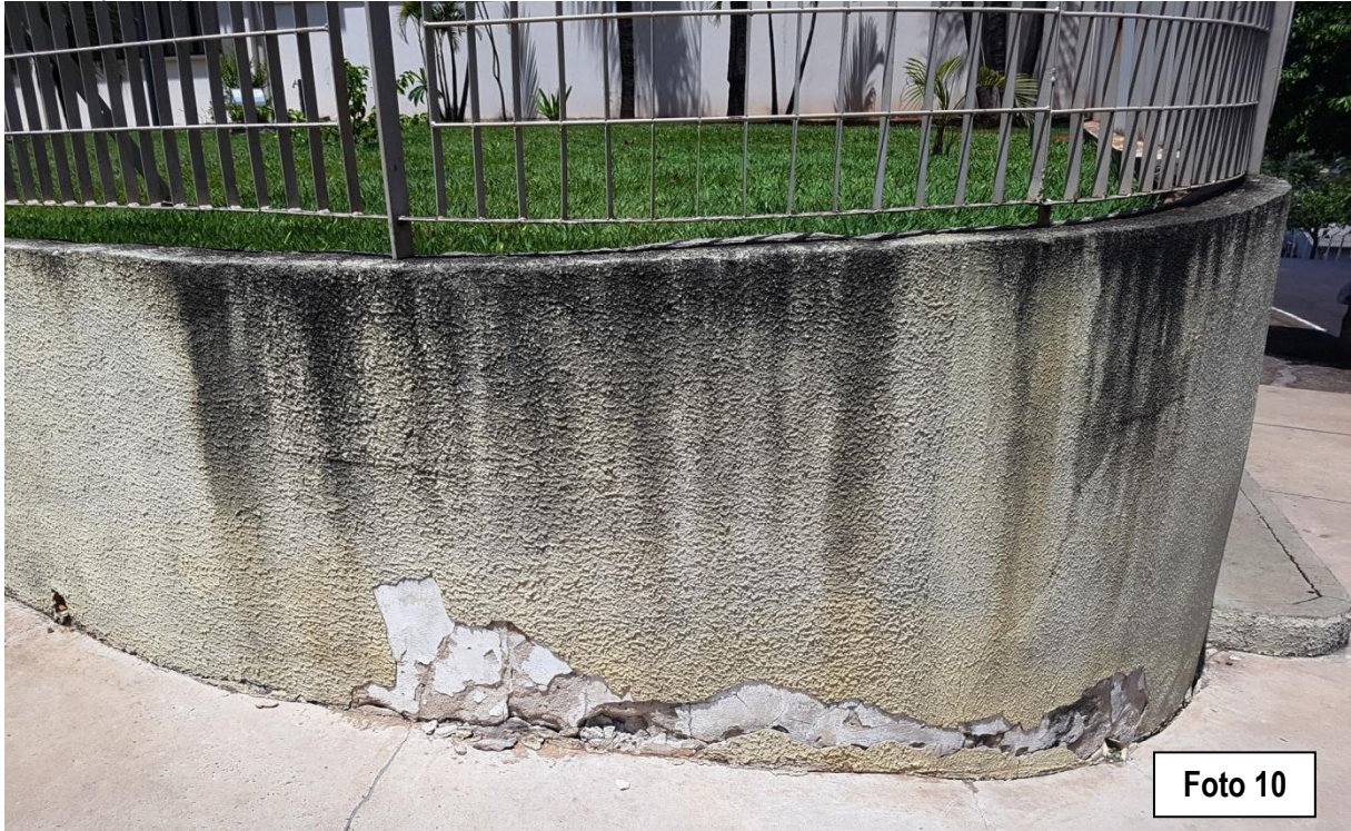
Fachada com parte do reboco deteriorado e pintura desgastada
