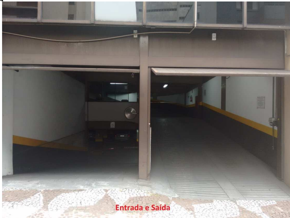
Figura 7: Ponto de Acesso do Edifício Anexo II na Rua Bittencourt Rodrigues
