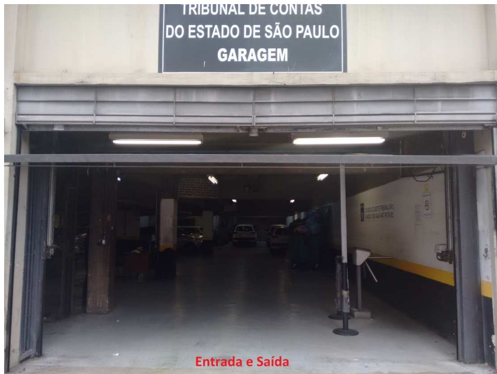
Figura 3: Pontos de Acesso na Rua 25 de Março nº 69
