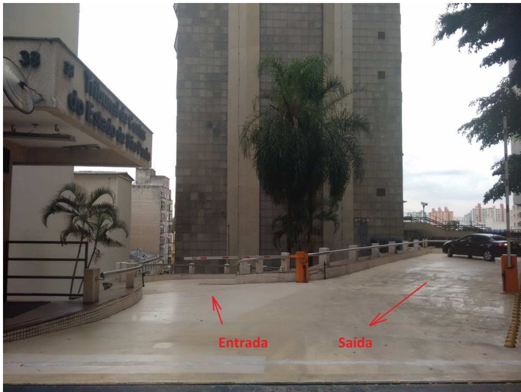
Figura 1: Pontos de Acesso na Rua Bittencourt Rodrigues nº 38
