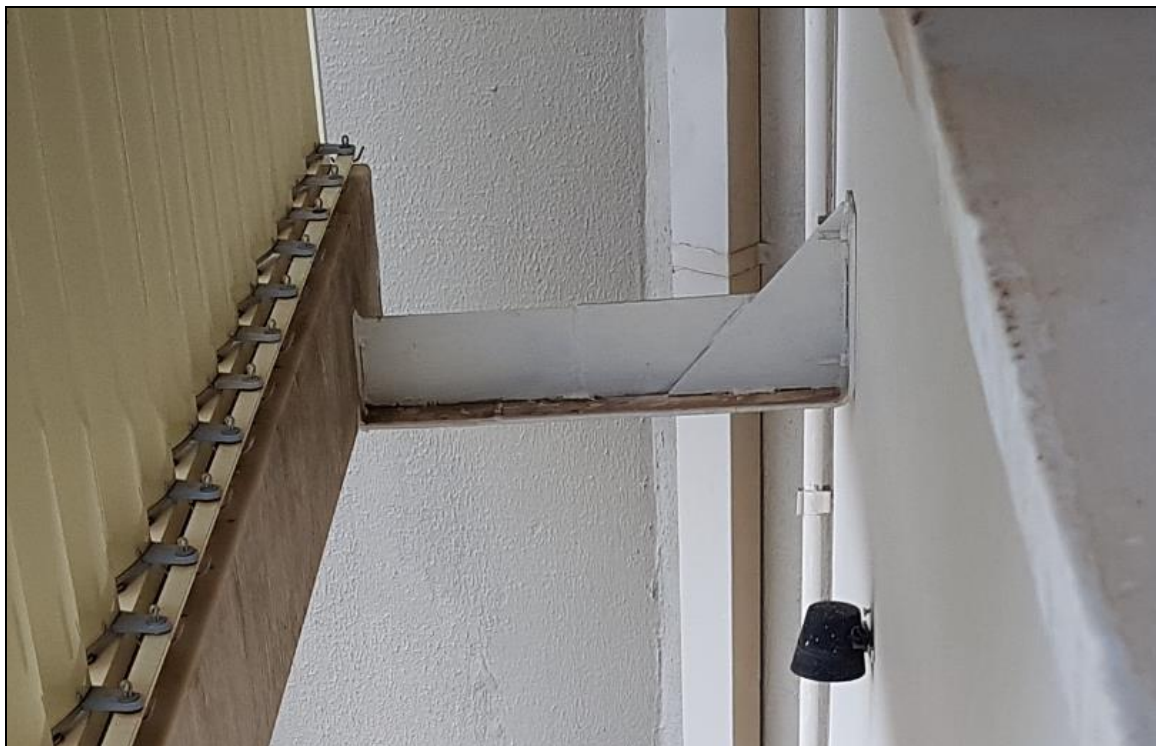
Figura 6 – Detalhe de ligação metálica existente, entre a estrutura do brise e o edifício
