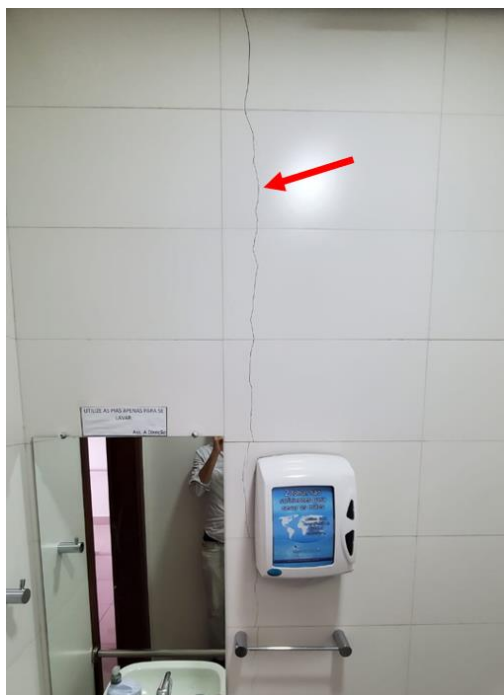
Imagens 14 e 15 – Locais onde deverá ser realizada a recuperação de fissura em revestimento cerâmico.
