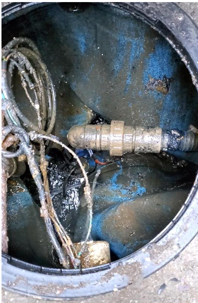
Imagem 1 – Visão interna da caixa atual da minielevatória, a ser substituída.
