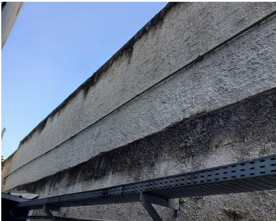
Imagem 4 – Visão de parte do muro do térreo (acima) e muro do subsolo (abaixo), nos quais deverá ser realizada a instalação dos rufos.
