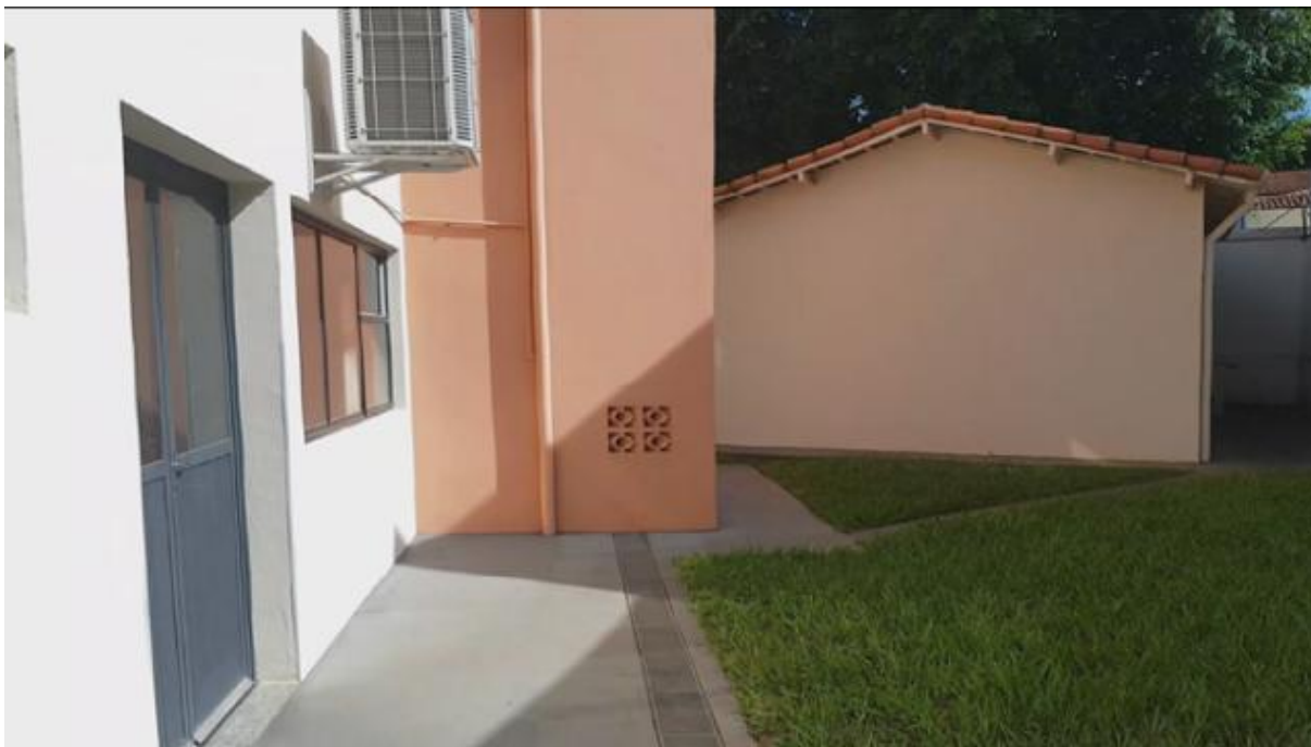
Figura 3 – Área de intervenção externa, no local de implantação da plataforma
