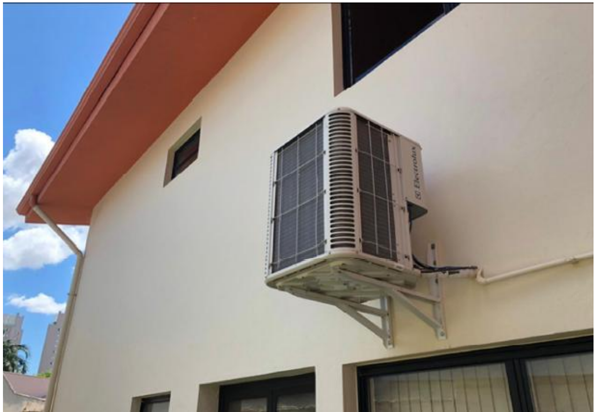
Figura 2 – Lado externo do pavimento superior, no local de implantação da plataforma
