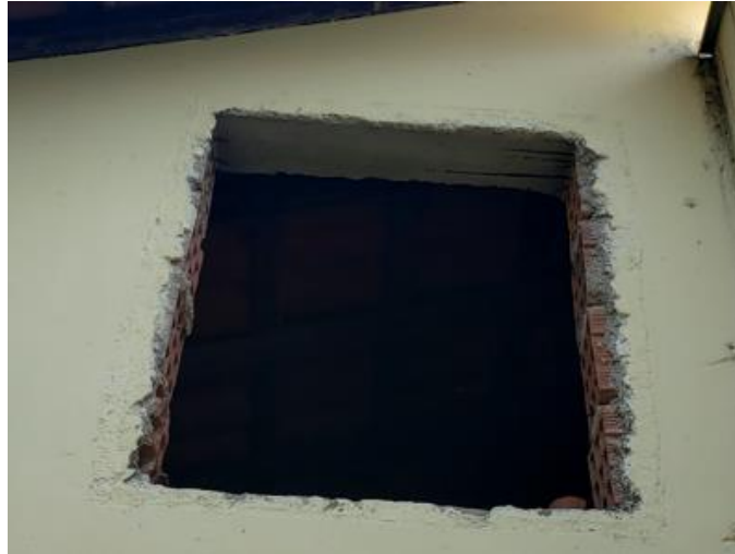
Imagem 9 – Local de instalação da porta de alumínio.
