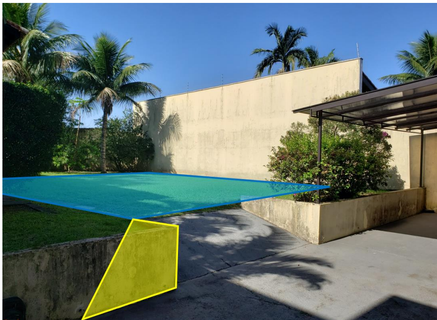
Imagem 4 – Local de instalação do “pisograma” (em azul) e o local de execução da complementação da rampa (em amarelo).
