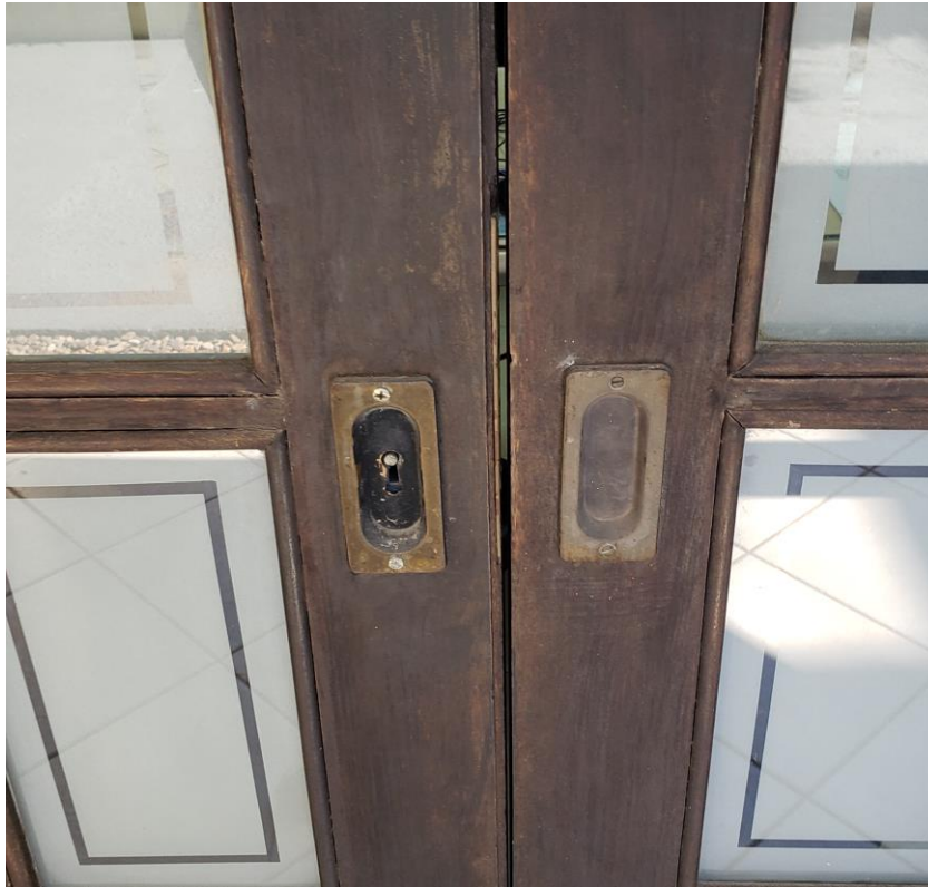
Imagem 11 – Fechadura a ser substituída.
