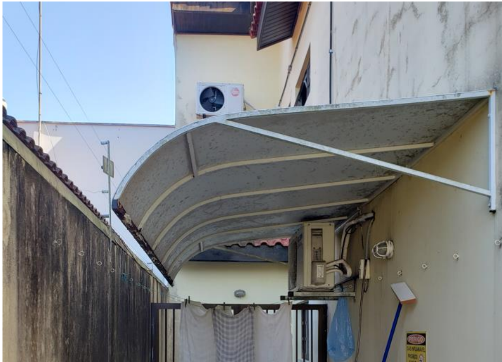
Imagem 17 – Cobertura a ser removida.
