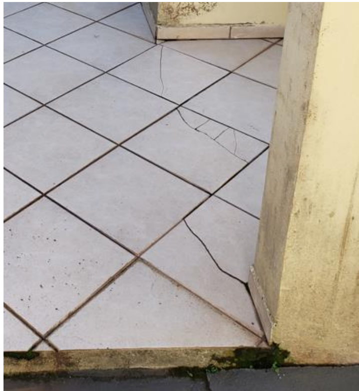
Imagem 2 – Local onde deverá ser realizada a junta.
