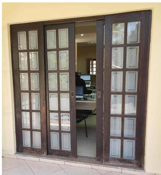
Imagem 10 – Uma das portas que terão os trilhos substituídos.
