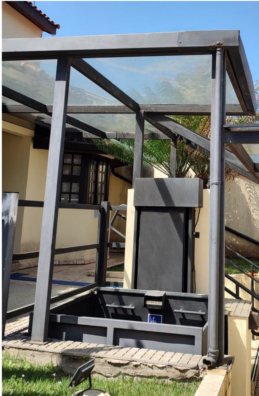
Imagem 18 – Cobertura da entrada em vidro e estrutura metálica.
