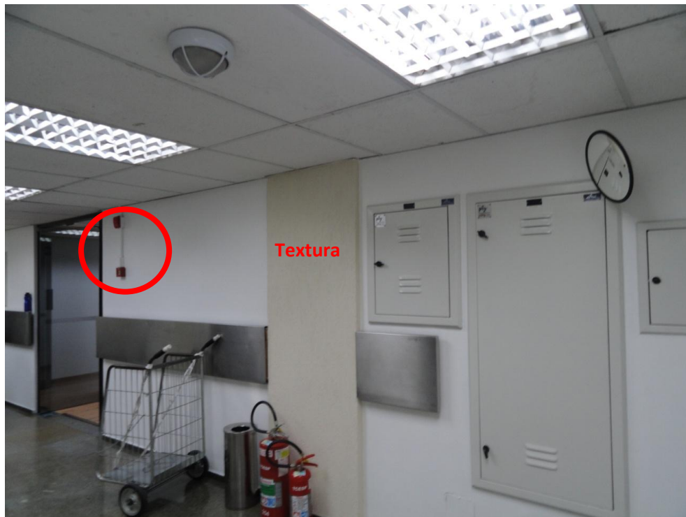
Foto 02 – Áreas com textura e condutele com botão quebra-vidro e sinere.
