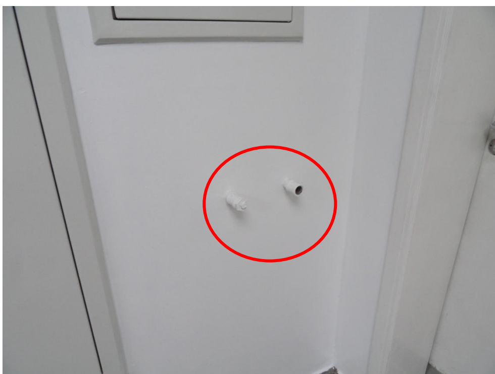
Foto 04 – Tamponamento das tubulações e chumbamento.
