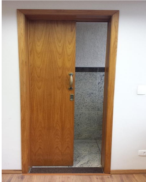
Foto 05 – Padrão de acabamento da porta.
