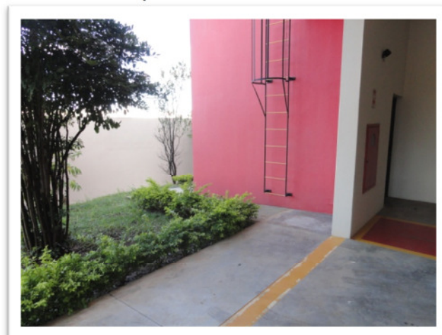
Lateral esquerda / fundo do prédio
