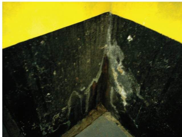
Imagem 14 a— Encontro da parede com o pilar
