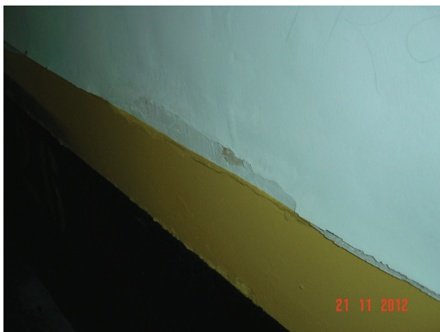
Imagem 03 a— Alvenaria em frente ao box nº 26—vista 01
