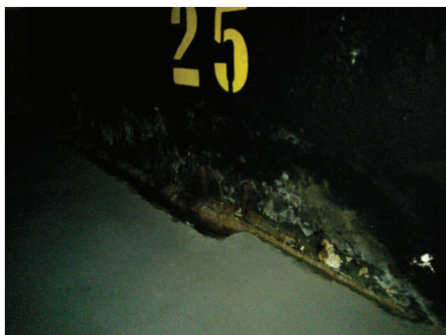
Imagem 13 b— Alvenaria localizada junto ao box nº 25
