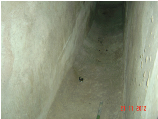
Imagem 01 a — Galeria paralela à alvenaria junto ao box nº 15—vista 01
