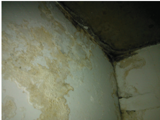
Imagem 02 a— Alvenaria interna da cabine de ar condicionado (próximo à laje do teto)
