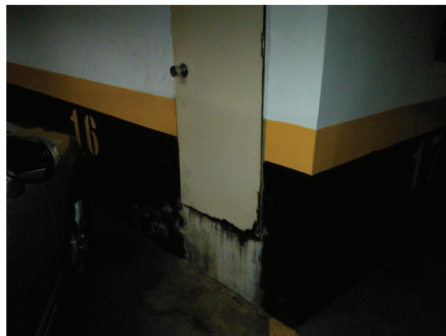
Imagem 10 a— Alvenaria da face externa junto ao box nº 16
