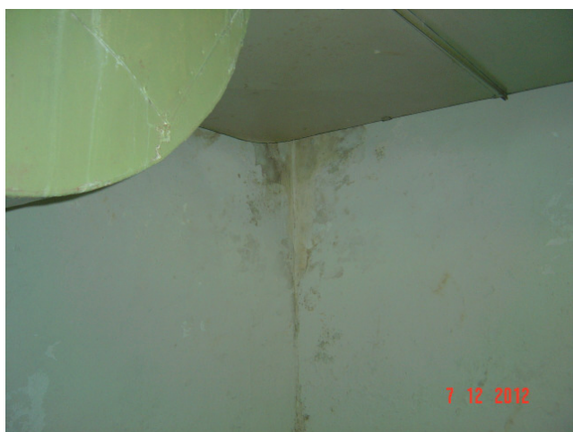
Imagem 15 b— Alvenaria entre o box nº 18 e a galeria
