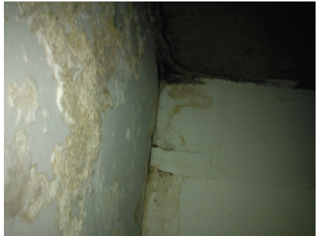
Imagem 02 b— Alvenaria interna da cabine de ar condicionado (próximo à laje do teto)
