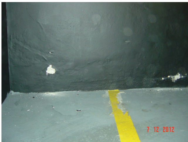
Imagem 05 b— Alvenaria em frente ao box 29
