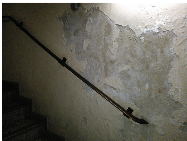
Imagem 06 a— Alvenaria da face interna da caixa de escada de acesso ao 2º subsolo
