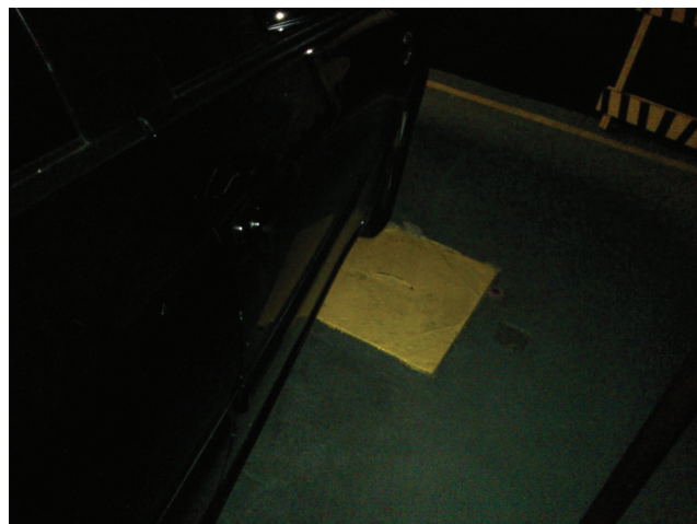
Imagem 12 b— Caixa de inspeção da caixa d'água auxiliar
