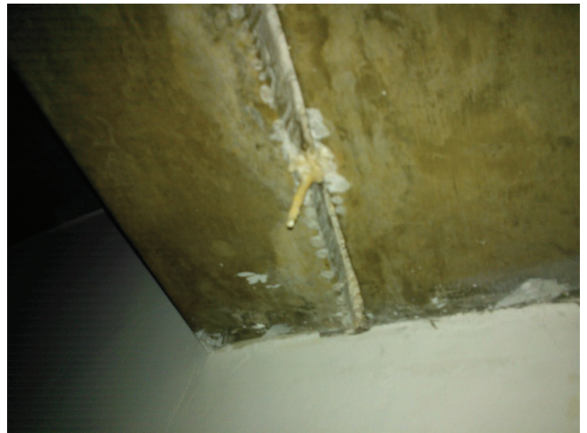
Imagem 01 b—Viga ao lado da casa de ar condicionado
