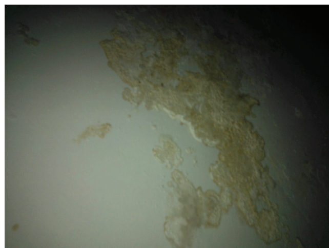
Imagem 04 d— Alvenaria entre a cabine de ar condicionado e o box nº 29 (vista superior)
