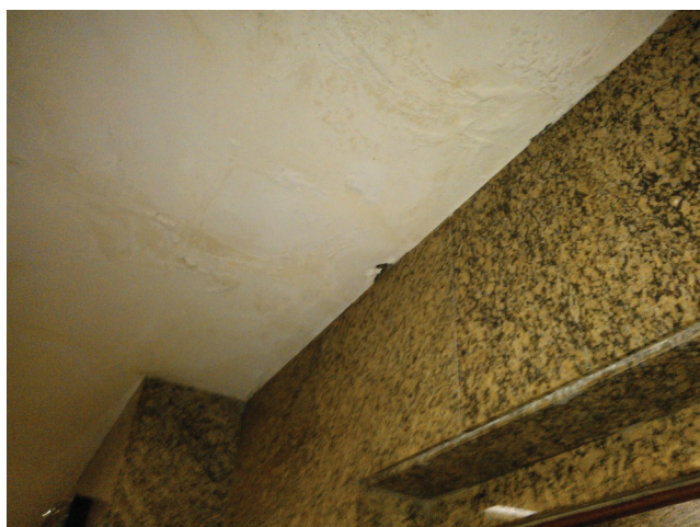
Imagem 08— Forro do Hall dos elevadores
