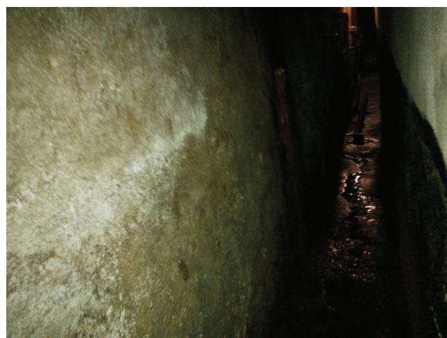
Imagem 04 e— Galeria junto ao box nº 30
