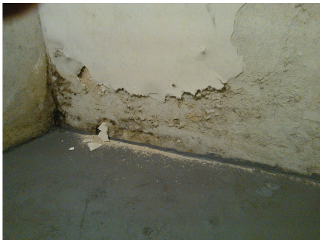
Imagem 03 — Alvenaria interna da cabine de ar condicionado (próximo ao piso)
