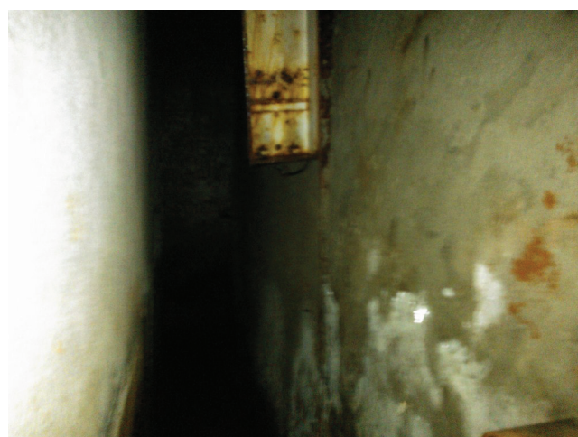
Imagem 04 g— Galeria junto ao box nº 30 (dreno)
