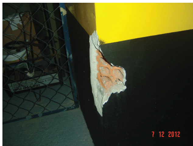
Imagem 02 — Pilar localizado junto ao box nº M6
