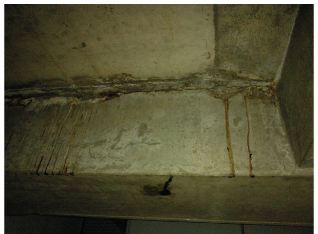
Imagem 11 c — Face interna da viga da casa de força
