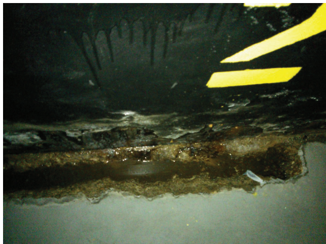
Imagem 13 d— Alvenaria localizada junto ao box nº 25
