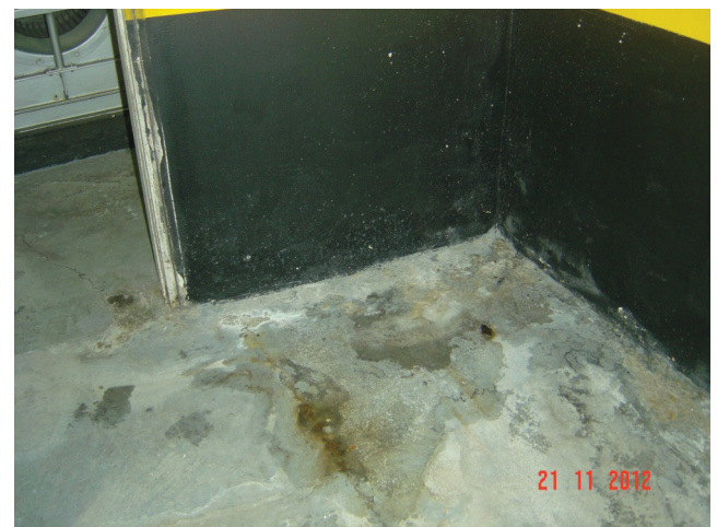
Imagem 02 b— Face externa da cabine de ar condicionado
