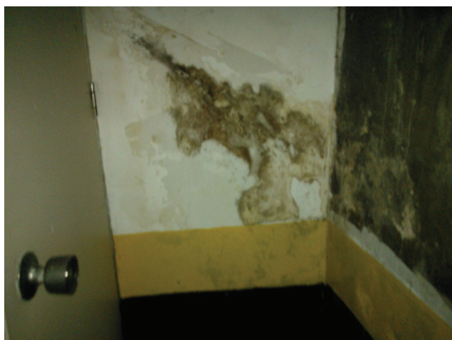
Imagem 14 c— Encontro da parede com o pilar ao lado do shaft
