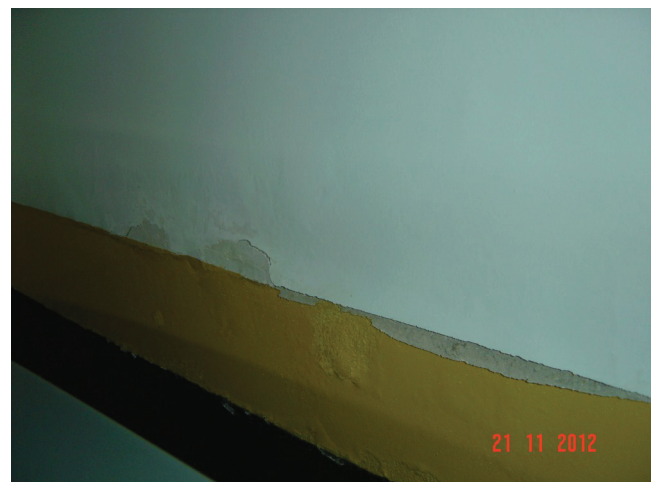
Imagem 03 b— Alvenaria em frente ao box nº 26—vista 02
