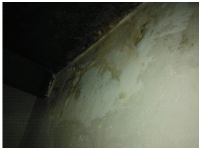
Imagem 04 c— Alvenaria entre a cabine de ar condicionado e o box nº 29 (vista superior)
