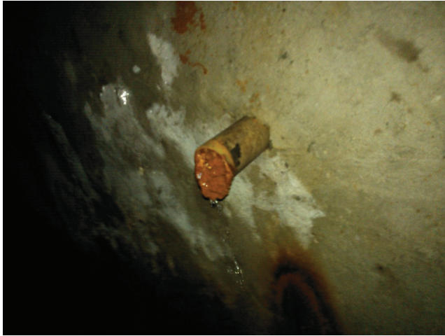
Imagem 04 h— Galeria junto ao box nº 30 (dreno lateral)
