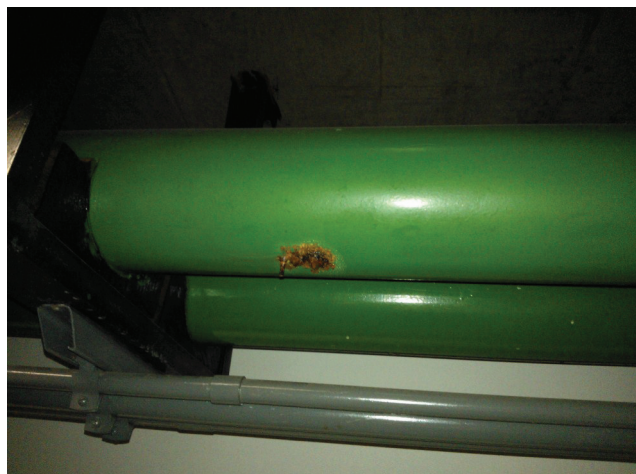
Imagem 01 a— Tubulação localizada na laje junto ao box nº 12
