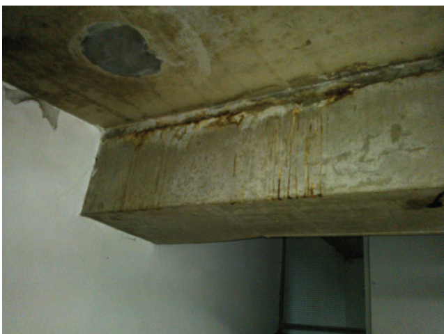
Imagem 11 b— Face interna da viga da casa de força
