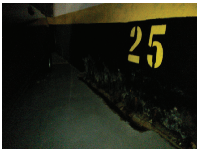
Imagem 13 a— Alvenaria localizada junto ao box nº 25
