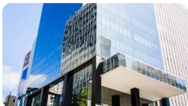
COND. ED. BELA PAULISTA Inspeção estrutural
