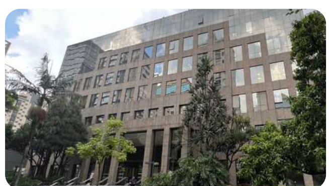
COND. ED. MADISON Inspeção umidade e estrutura
