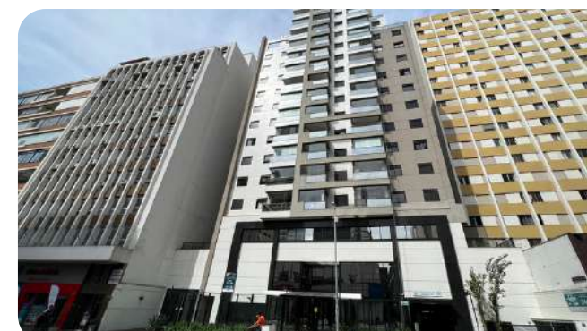
COND. ED. JUST BRIGADEIRO Manutenção das fachadas
