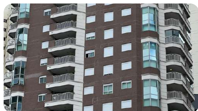
ED. ESTANCONFOR Inspeção de fachada
