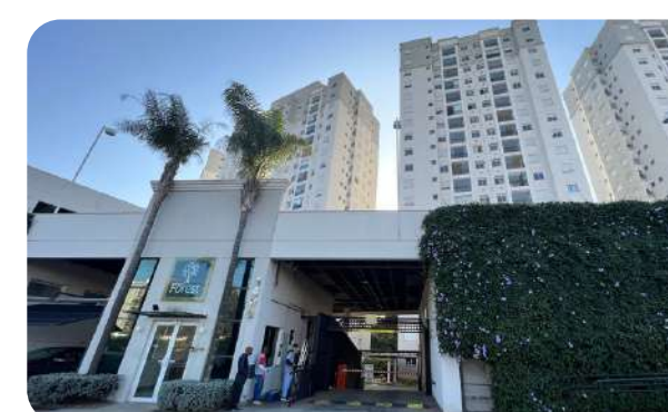
COND. ED. FOREST Inspeção estrutura e umidade
