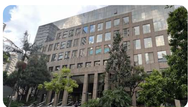
COND. ED. MADISON Inspeção umidade e estrutura
