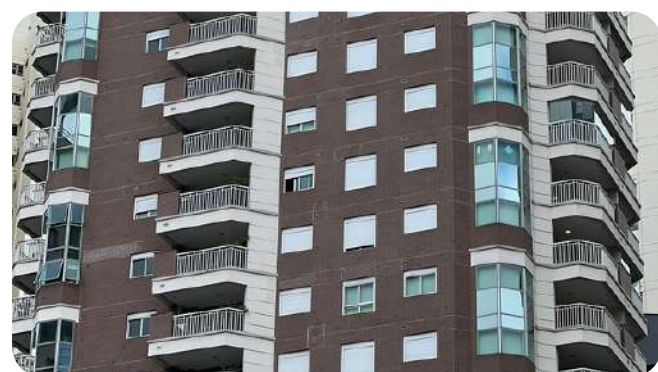
ED. ESTANCONFOR Inspeção de fachada
