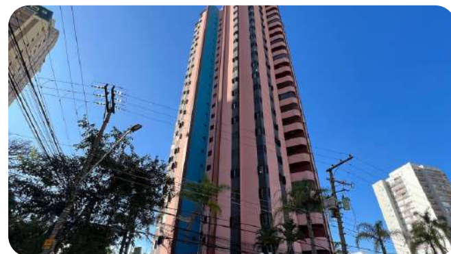
PIAZZA DELLA FONTANA Inspeção de fachada
