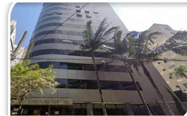
COND. ED. CARNAUBEIRAS Inspeção das fachadas
