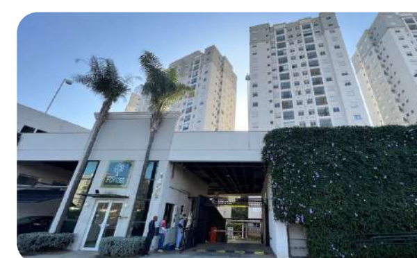
COND. ED. FOREST Inspeção estrutura e umidade
