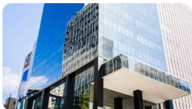
COND. ED. BELA PAULISTA Inspeção estrutural
