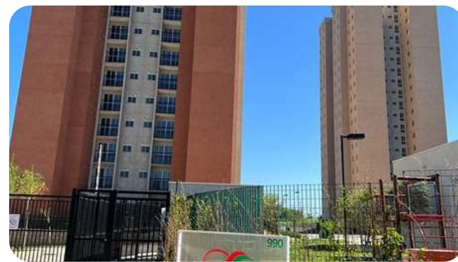
CONSTRUTORA SANTA ÂNGELA Inspeção de recebimento de obra
