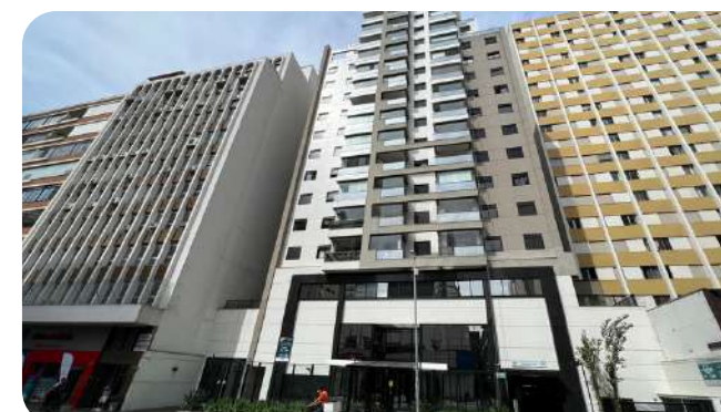
COND. ED. JUST BRIGADEIRO Manutenção das fachadas
