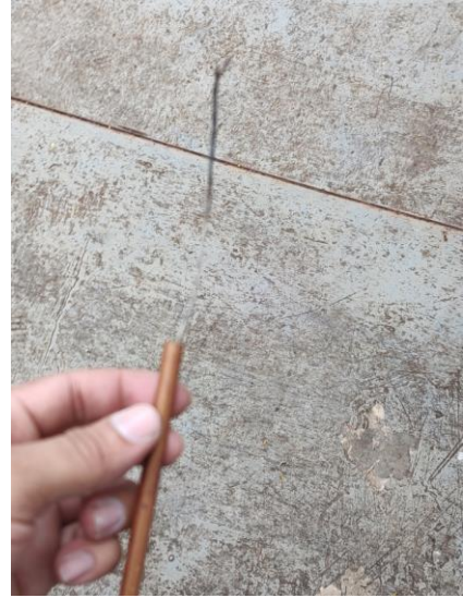
Foto 4: Elo fusível rompido na descarga atmosférica.
