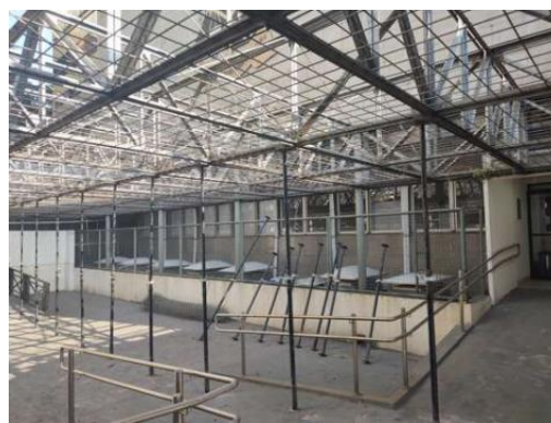
Foto 4 – Cobertura metálica, anteriormente e desmonte
