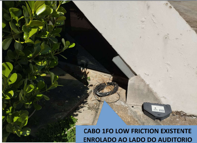
Cabo 1fo Low Friction, enrolado neste ponto do Auditorio. Cabo 1fo Low Friction, enrolado na parte externa do Auditorio.
