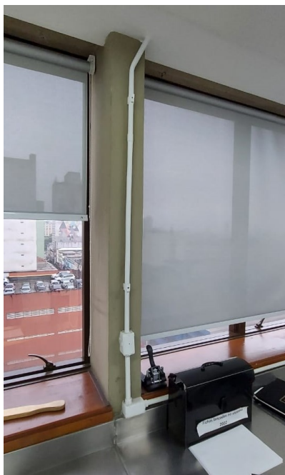
Figura 3 - Trecho de eletroduto a ser remanejado
