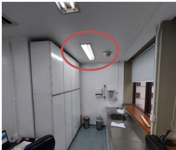
Figura 4 - Luminária com mudança de interruptor
