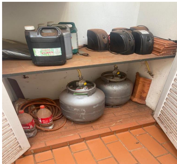
Imagem 1: Botijões existentes e local de instalação
