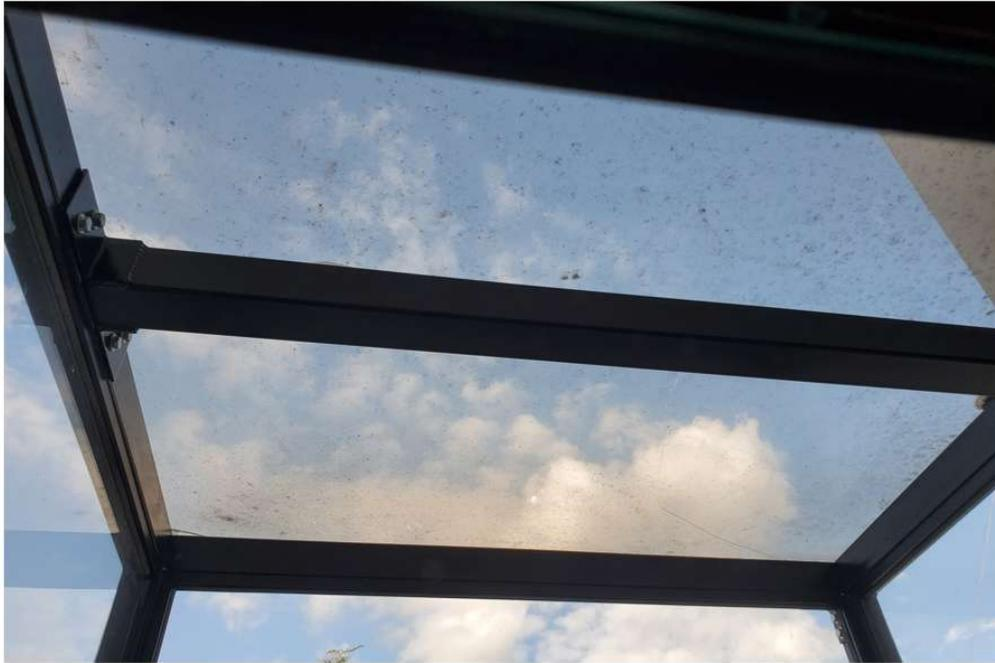
**Imagem 14 – Vidro a ser substituído no topo da caixa de corrida da plataforma elevatória.**
