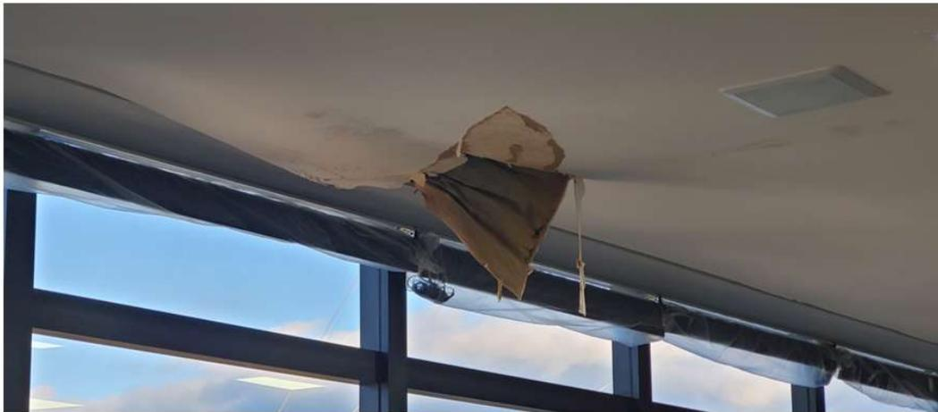
**Imagem 8 – Exemplo de área de forro a ser reparada - detalhe.**
