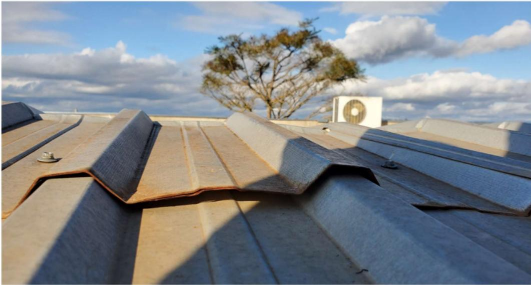
**Imagem 2 – Encontro entre a cumeeira e a telha, que deverá ser calafetada com fita aluminizada autoadesiva.**
