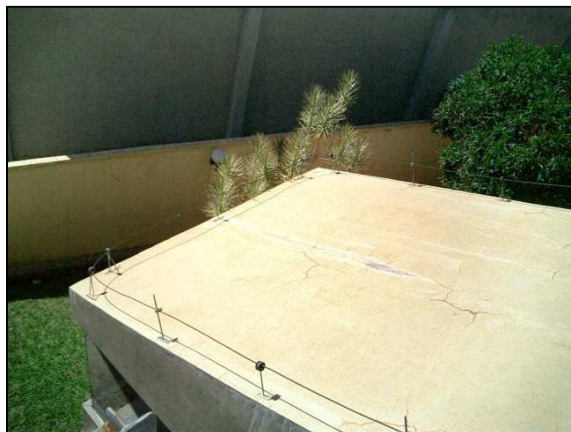
Imagem 6 – Vista parcial da laje da caixa de escada
