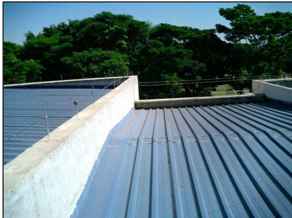
Imagem 1 – Vista parcial do telhado
