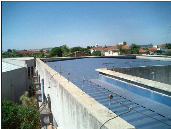
Imagem 2 – Vista parcial do telhado
