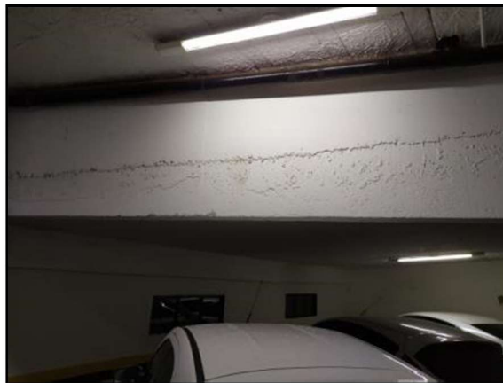
Foto 04 – Foto ilustrativa de elemento estrutural a ser tratado
