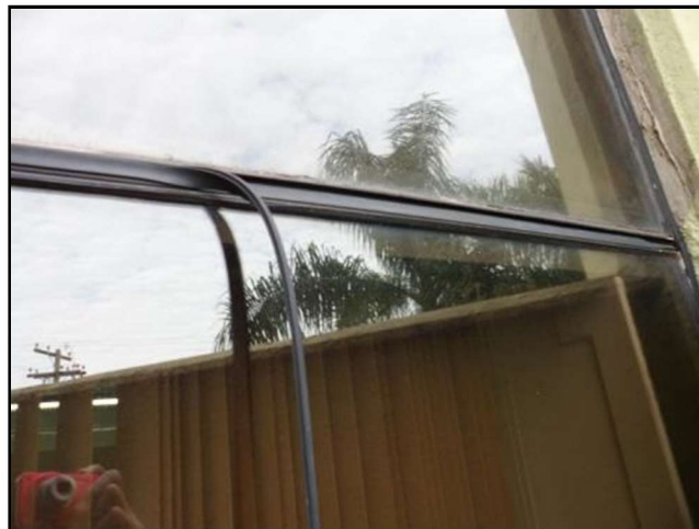
Foto 27 – Foto ilustrativa de guarnição elastomérica existente
