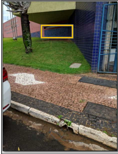
Foto 19 – Foto ilustrativa do local onde será demolida a alvenaria sob túnel de acesso principal
