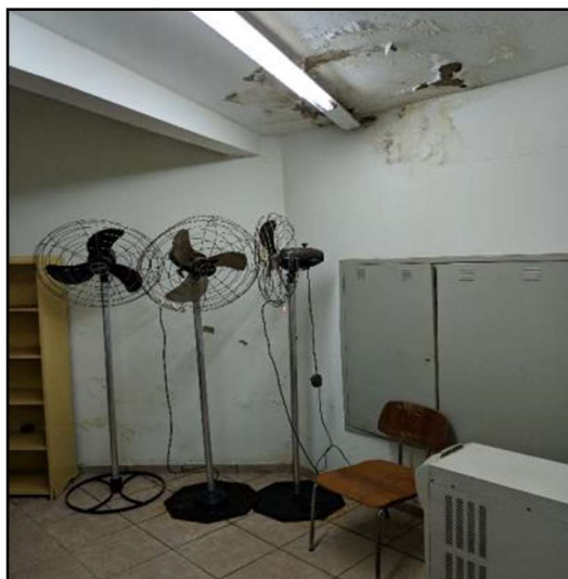
Foto 26 – Foto ilustrativa das paredes que receberão impermeabilização bicomponente
