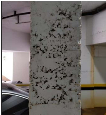
Foto 02 – Foto ilustrativa de elemento estrutural a ser tratado
