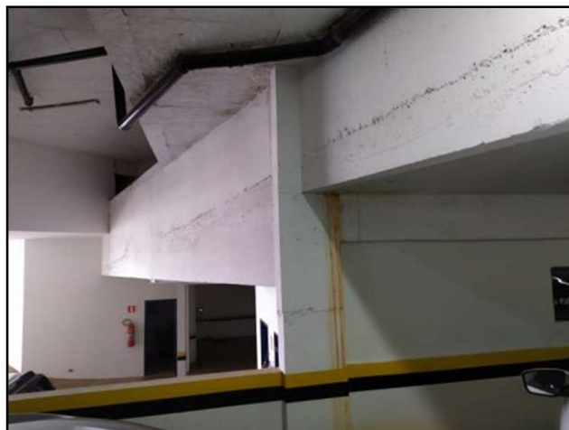
Foto 05 – Foto ilustrativa de elemento estrutural a ser tratado
