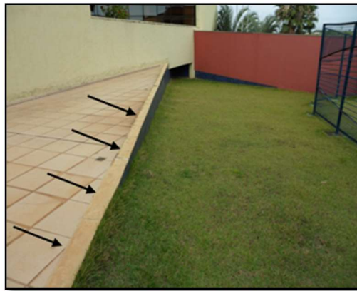
Foto 15 – Foto ilustrativa de guia em alvenaria a ser removida
