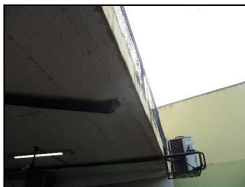
Foto 21 – Foto ilustrativa do local onde se encontra o ar-condicionado a ser realocado
