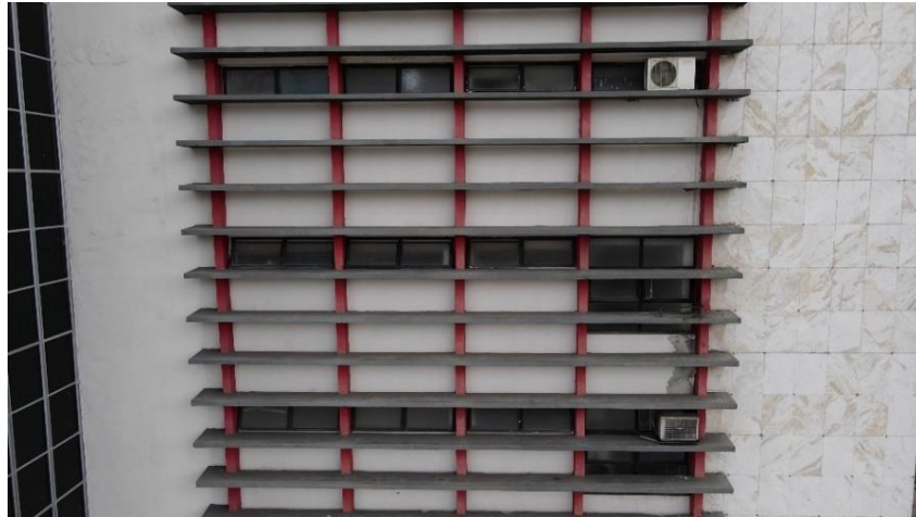
Detalhe dos brises e pilaretes. Foto outubro de 2022, acervo CDHU
