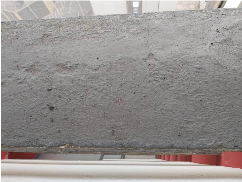
Foto 10 – Face superior do Brise 61, lado B, com argamassa esfarelando.
