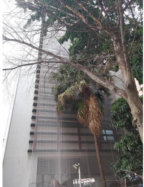
Foto 8 - Fachada com brises-Lado B.
