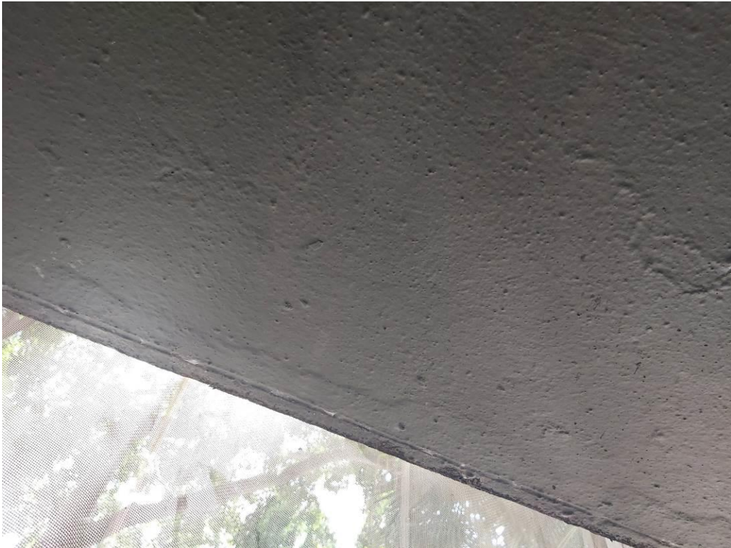
Foto 14 – Vista da pingadeira do Brise 4, lado B.
