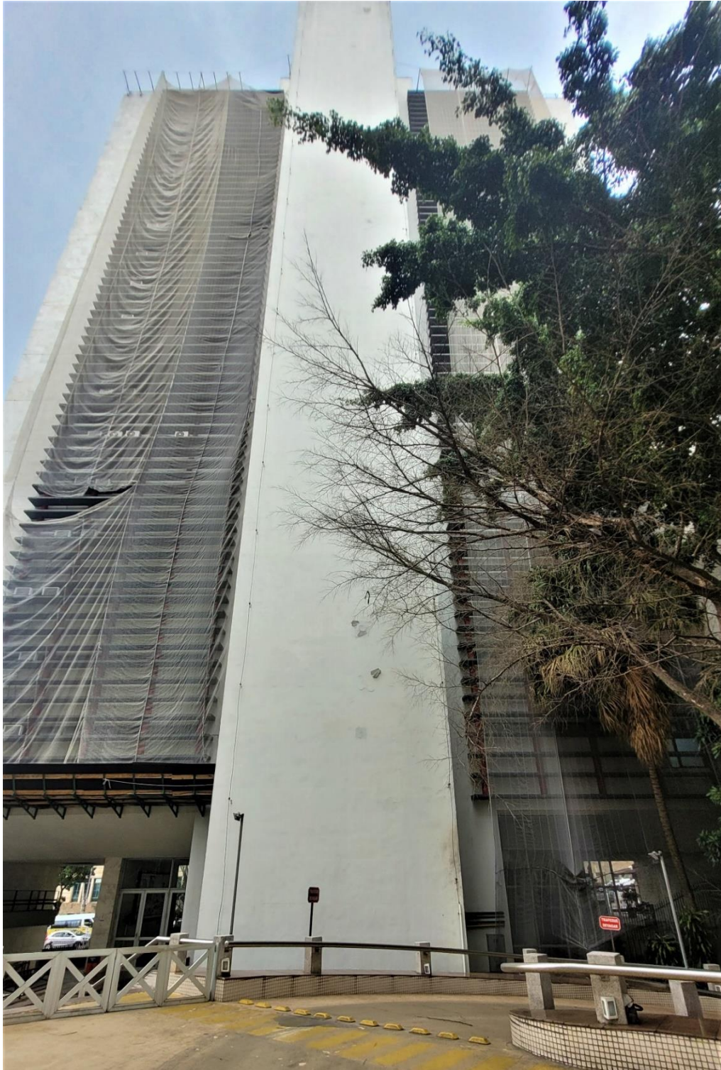
Vista da fachada dos fundos dos brises com proteção de tela e da caixa de escada. Foto outubro de 2022, acervo CDHU
