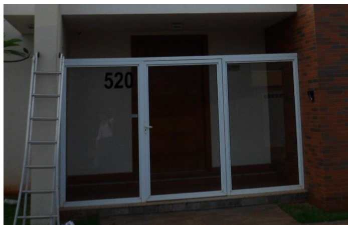
Foto – local da fixação do adesivo (bandeiras à direita)
