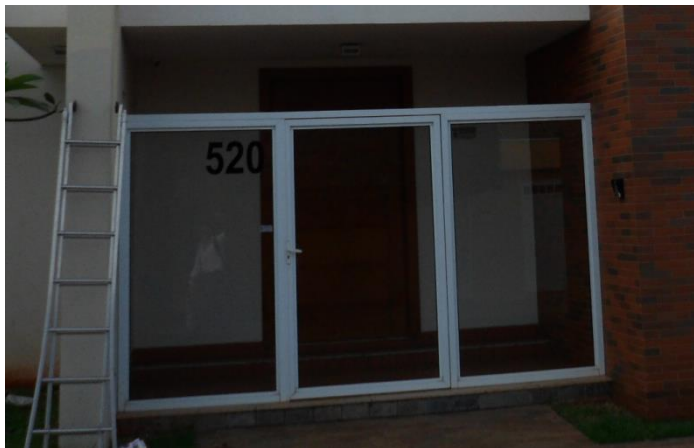
Foto – Fechamento de vidro.
