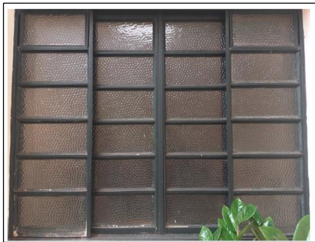
Foto 1 – Janela de aço e vidro
