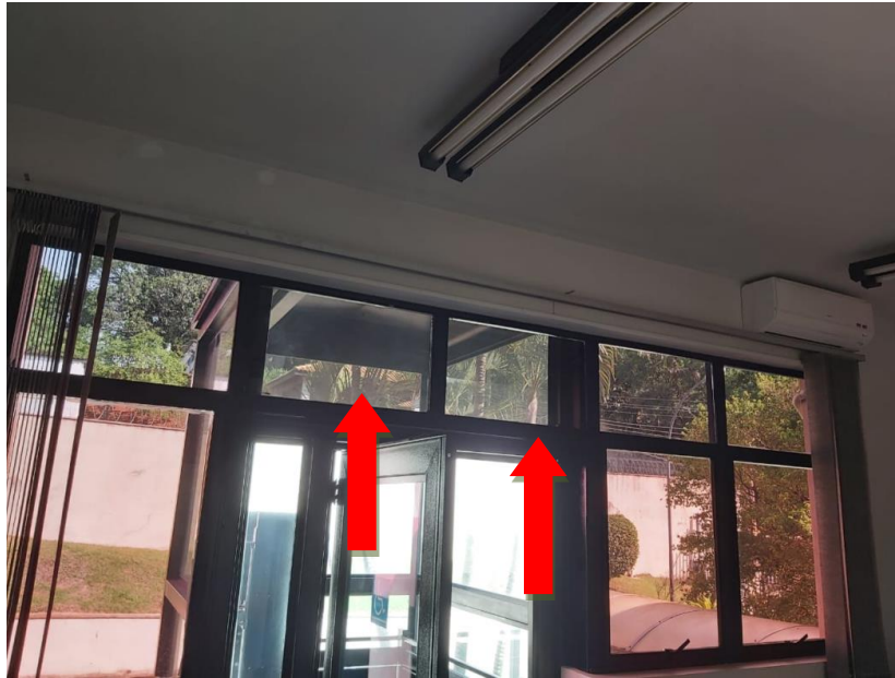
Figura 2 - Janelas a substituir
