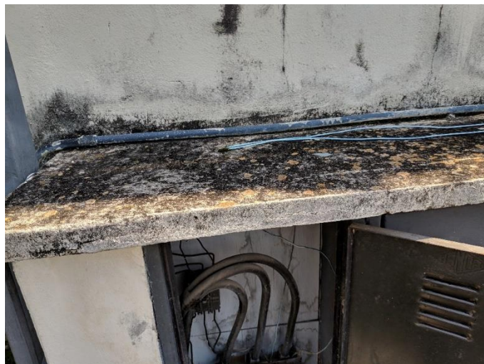
Figura 1 - Fiação aparente
